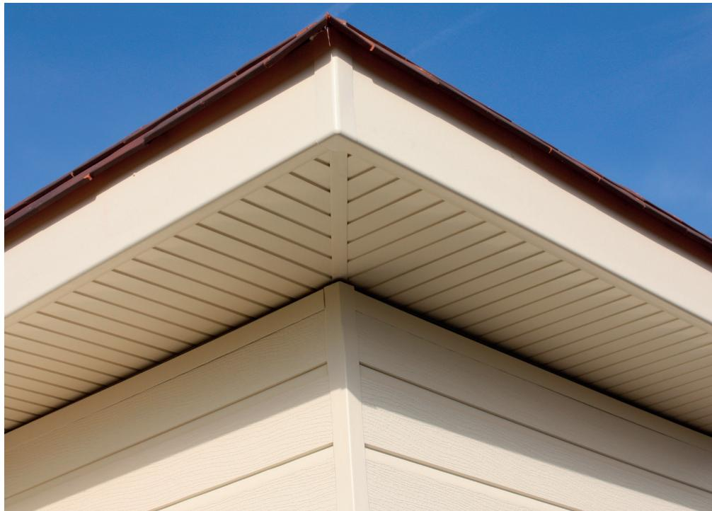
**NL** Met specifieke afwerkingsprofielen kunnen de holle profielen verbonden worden mits het respecteren van een uitzettingsvoeg van 5mm.
