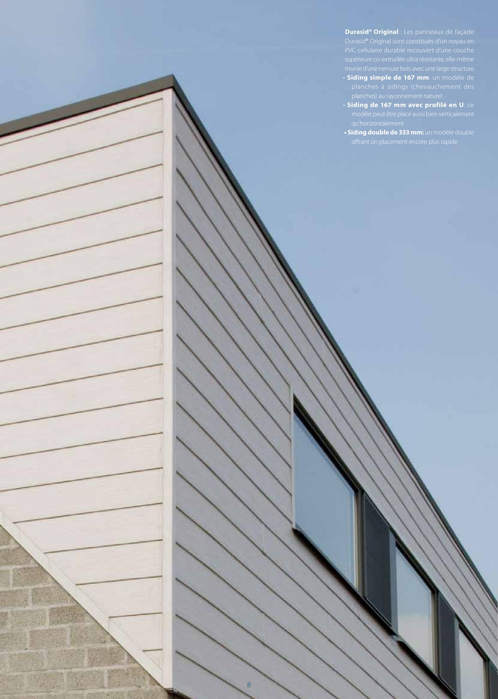
**Durasid® Original** : Les panneaux de façade Durasid® Original sont constitués d'un noyau en PVC cellulaire durable recouvert d'une couche supérieure co-extrudée ultra résistante, elle-même munie d'une nervure bois avec une large structure.
