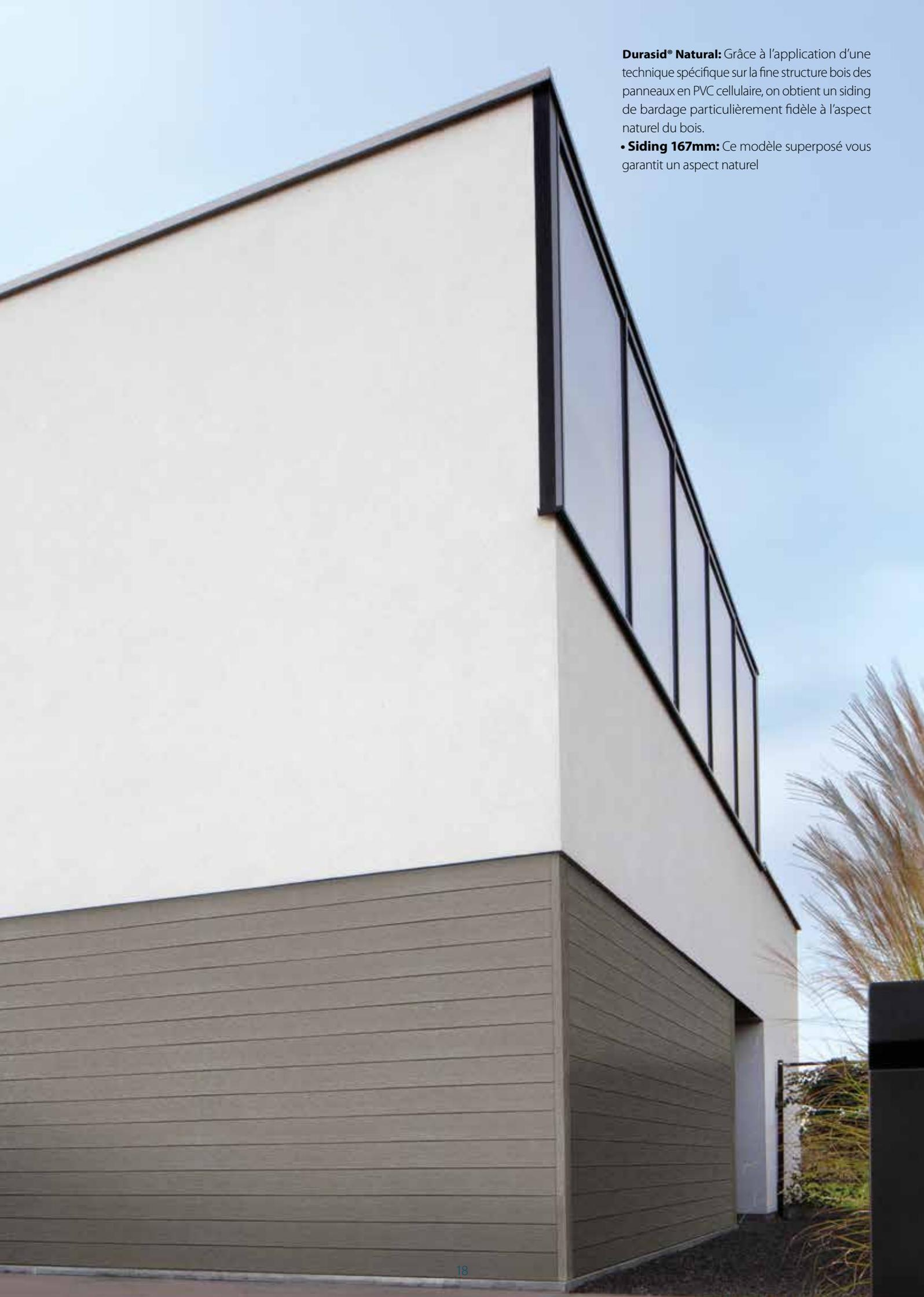
**Durasid® Natural:** Grâce à l'application d'une technique spécifique sur la fine structure bois des panneaux en PVC cellulaire, on obtient un siding de bardage particulièrement fidèle à l'aspect naturel du bois.
